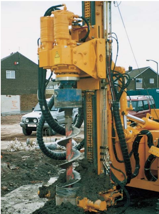
Mikropfahlbohrungen Ø 344 mm Micro-piles Ø 344 mm
